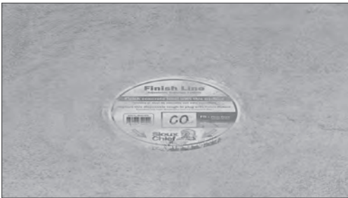
Pour Concrete Flush with Plug
